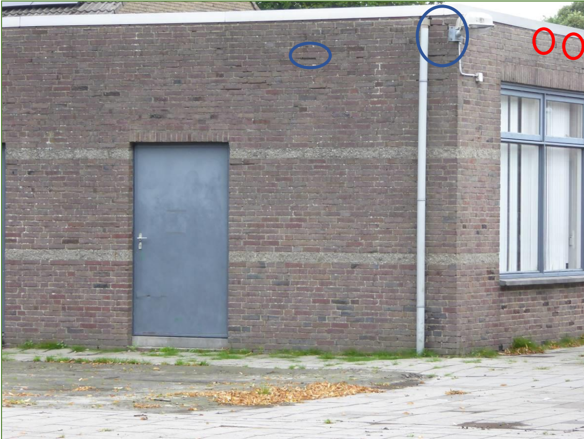
Foto 3: het gebouw vanaf het schoolplein. De stootvoegen (rood) en scheuren (blauw) in de muur kunnen door vleermuizen worden gebruikt.
