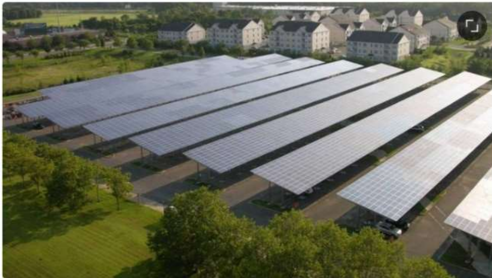
Een algemene impressie van de carports met zonnepanelen (Foto: Blue Oak Energy).
