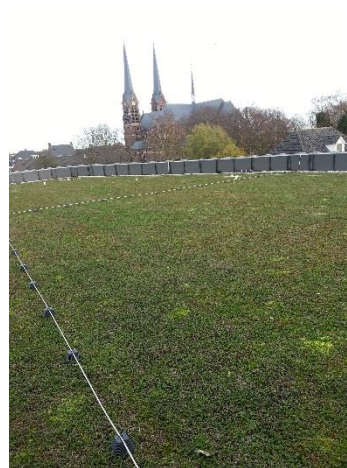
Afbeelding 24 Rioolwerkzaamheden in de Gasthuisstraat en groen dak gemeentehuis.
