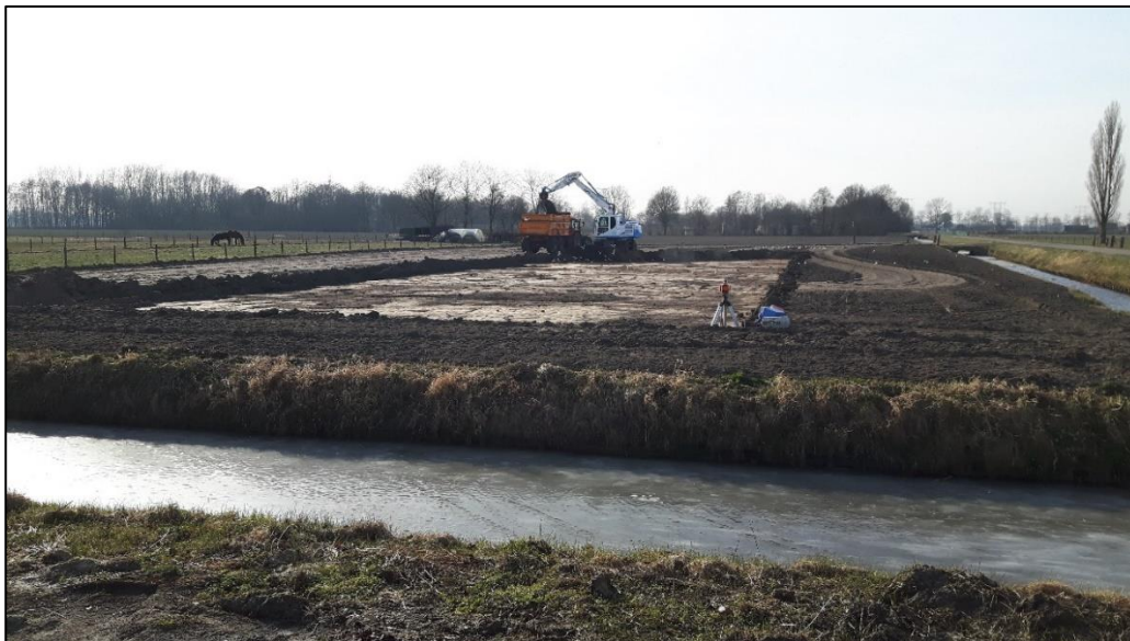
Figuur 6: Aanleg van waterberging De Roei ten behoeve van inundatie
